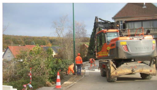
Vue sur le chantier
